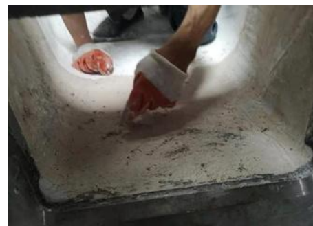
QUICK-FIRE® ONE 86 スパウト部の補修に使用
