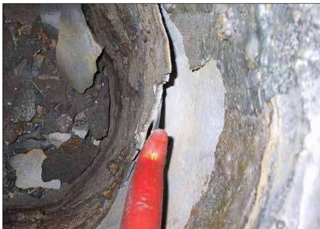
FIGURA 1 – Capa de sacrificio con la pintura a base de magnesita, T-Coat .
